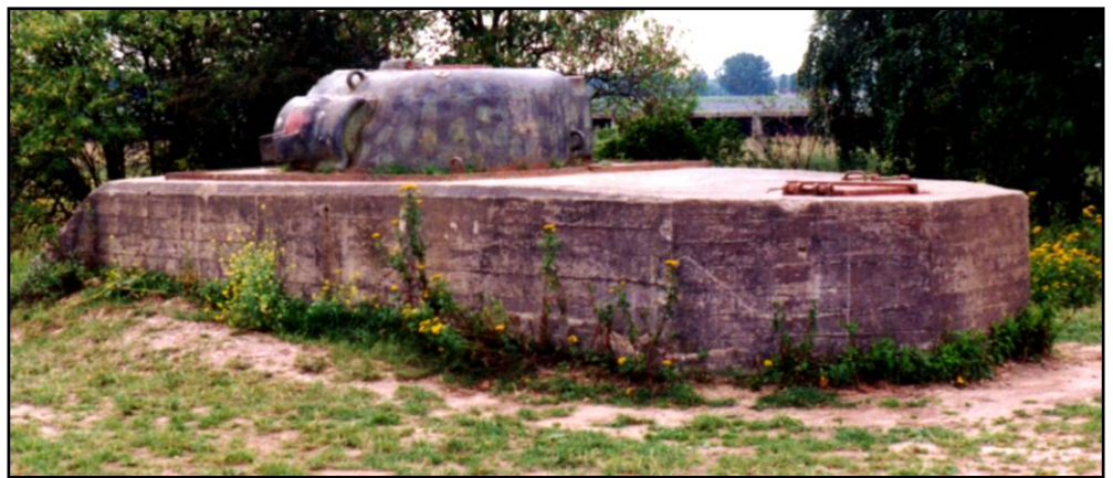
Panzerkassematte (Kanone), leichte Ausf. mit Eingang von oben
