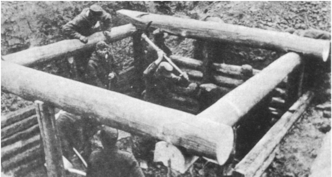
Aufbau eines Blockhausbunkers
